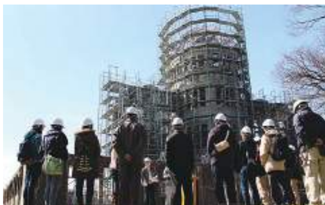
広島県広島市 原爆ドーム健全度調査見学
